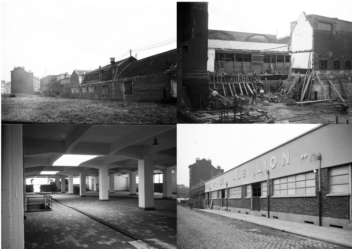
Vue du chantier du hangar aux primeurs. En haut à g., terrain vague le long de la rue J.-B. Janssen avant destruction des anciens bâtiments ; à d., construction des caves et fondations le long de la rue couverte. En bas à g., intérieur du nouvel hangar ; à d., vue sur le bâtiment en cours d'achèvement depuis la rue. AD. Fonds iconographiques, 1934.
