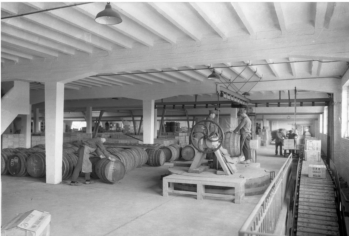
*Étage du nouvel hangar avec stockage des barriques, des caisses à vent. Un tapis roulant assure la liaison avec l'étage inférieur et les entrepôts voisins dont les cloisons ont été retirées. On aperçoit encore au fond de l'image l'ancienne charpente métallique mansardée du magasin voisin. AD, fonds iconographiques, c. 1935.*
