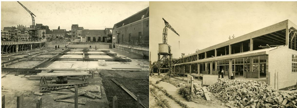
Chantier du nouvel entrepôt en 1934 : à gauche, caves et fondation vues depuis l'allée parallèle vers la rue couverte, à droite, élévation des deux niveaux et prolongation du quai de chargement des trains vues depuis la zone de triage ferroviaire à l'arrière du site. AD, fonds iconographiques, 1934.
