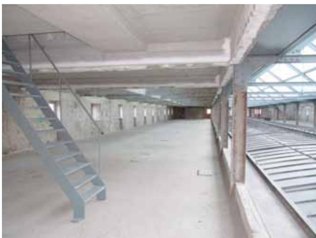
Sous-toiture rénovée, au niveau de la verrière, perspective côté du site et canal. La double verrière est bien visible, la rénovation a retiré les cloisonnements, 2010.
