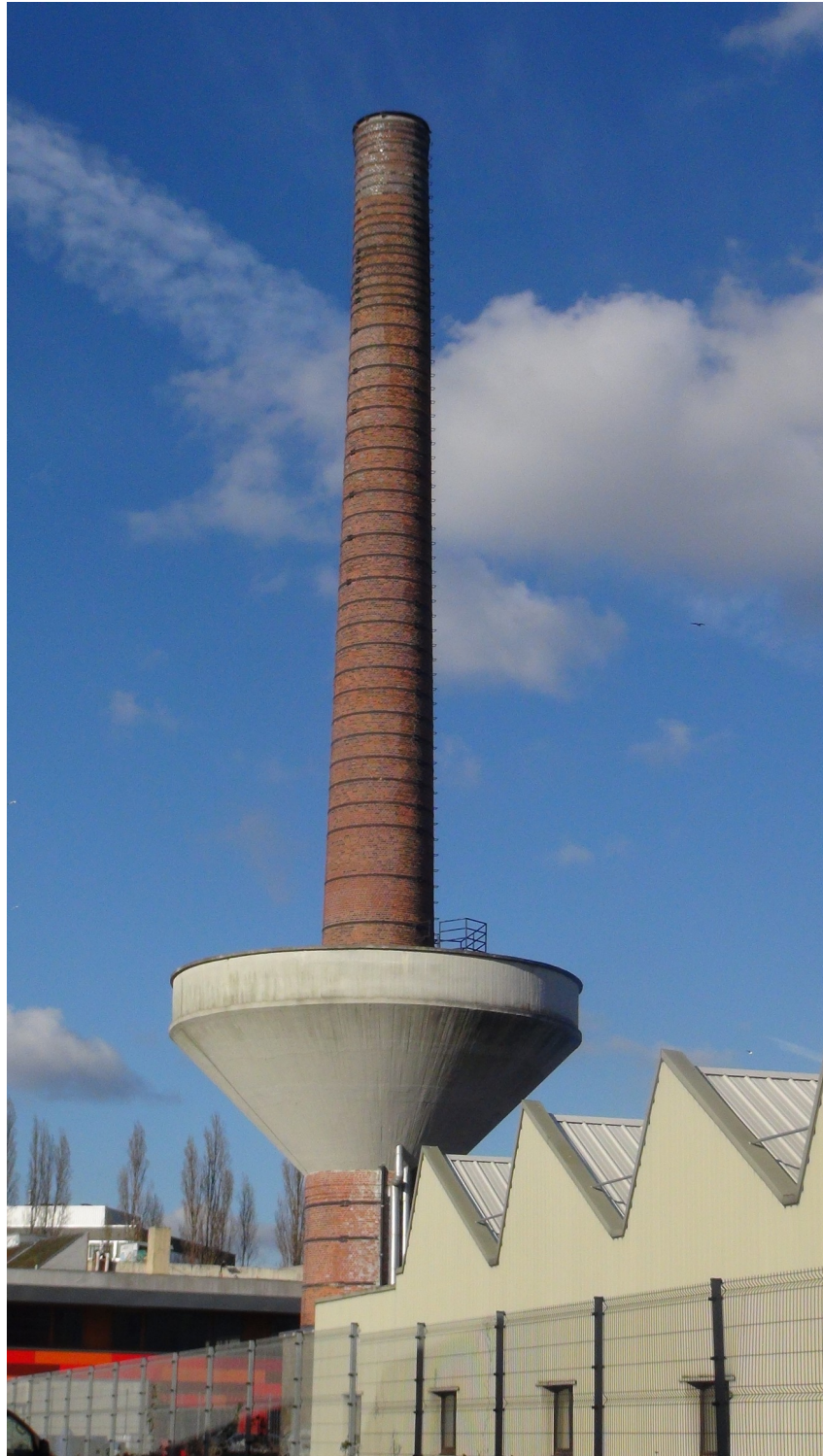
La cheminée réservoir de l'usine du linge (1938) à l'arrière de la partie préservée du hall de 1931 recouvert d'un bardage métallique. Photo : Guido Vanderhulst, 2016.
