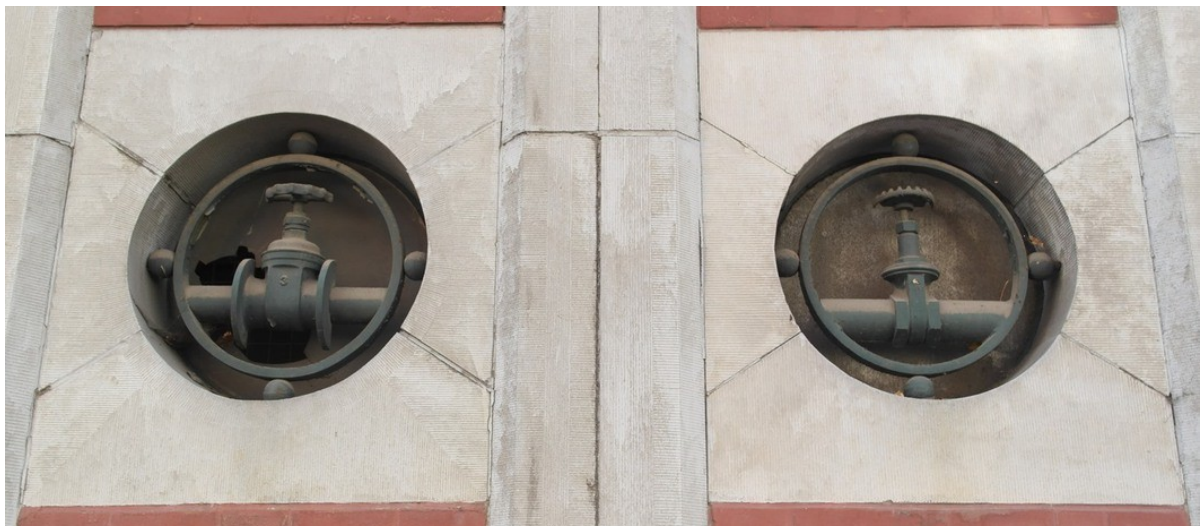
Figure 6: Oculi présentant des éléments de robinetteries ornementaux dans les colonnes latérales aux portes de garage. Photo : Direction des Monuments et des Sites – SPRB, 2015.
