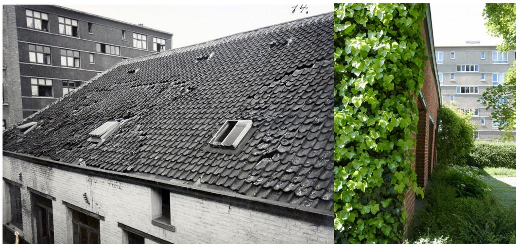
Figure 12: Dommages subis par la toiture de la halle après l'explosion des ponts du canal le 17 mai 1940 et état actuel du mur sud-est. Source : AGR2, Dommages de guerre, Brabant, dossier 35.830 et photo personnelle, mai 2019.
