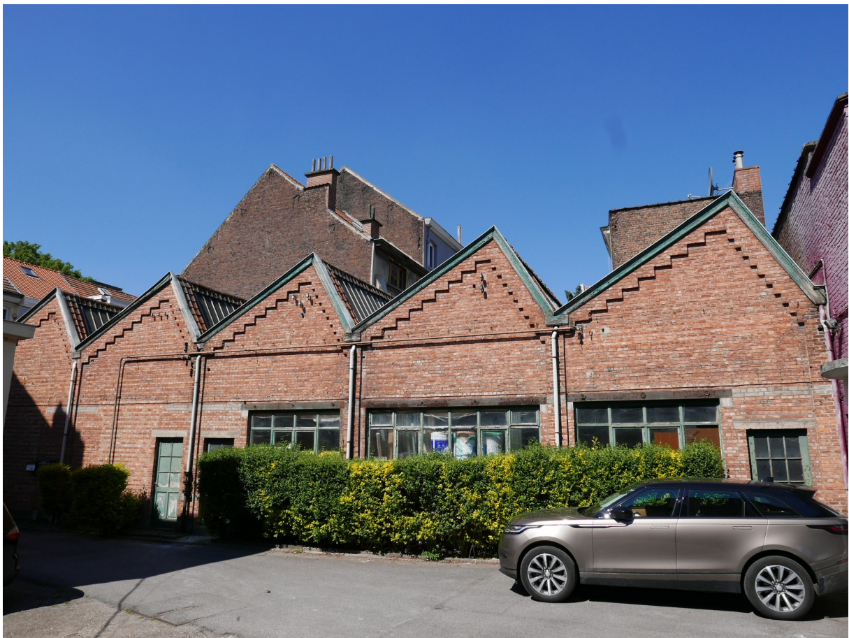
Figure 9: Anciens magasins de 1922 dont les baies ont été modifiées. Photo personnelle, juin 2019.
