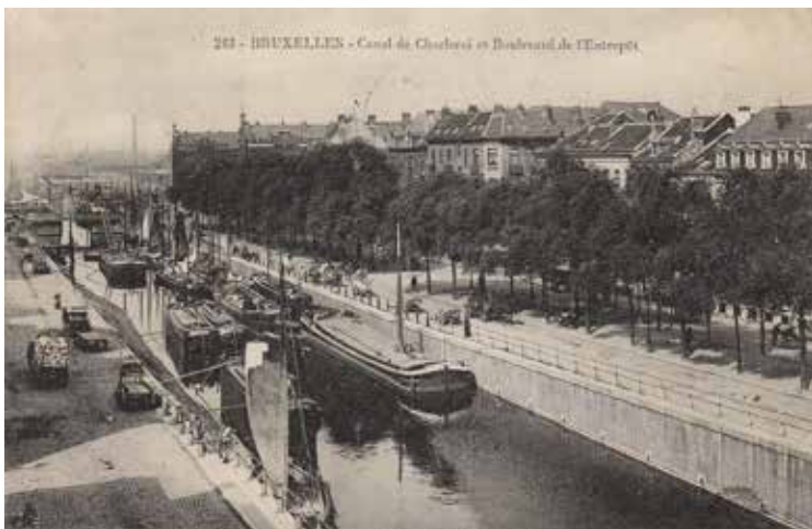
Canal de Charleroi à hauteur du Petit Château au Boulevard de l'Entrepôt – le quai côté Bruxelles est neuf, celui de Molenbeek en attente (Carte postale collection G. Vanderhulst).
