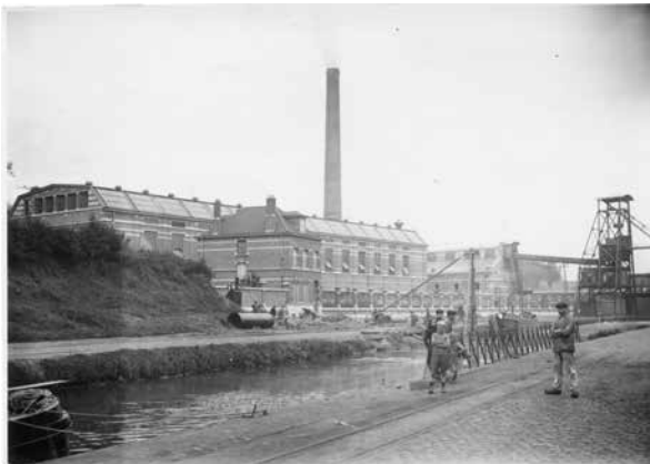
Centrale STIB durant des travaux le long du canal, avant 1925- le portique de chargement est bien visible (Fonds Mupdofer - il642).
