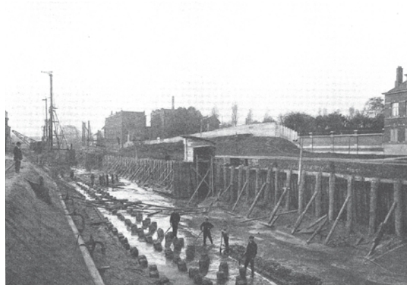
Travaux pour l'élargissement des canaux houillers – au fond la Meunerie Moulart – à droite la maison de direction de la Centrale électrique principale des tramways bruxellois (Archives BESIX).
