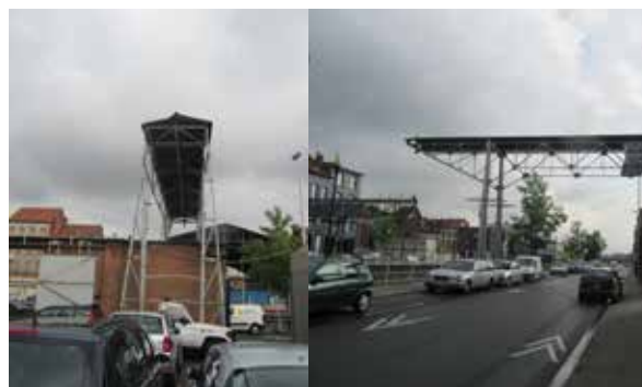
Portique vue de face – photo G.Vanderhulst
