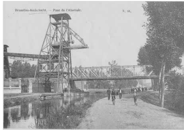
Pont dit de l’abattoir. Un train portant le bétail emprunte cette voie depuis la Gare de l’Ouest vers l’abattoir( à droite). Ce qui importe ici est le portique de déchargement des péniches – avant 1922 - Carte postale.
