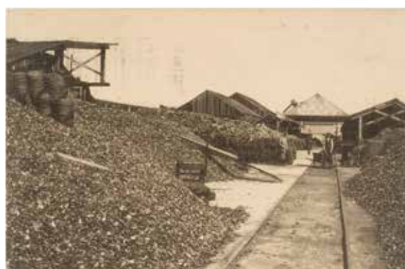
Tas de charbons des dépôts de la Maison du Peuple (DE45 – 126, Fonds Abeels -DEXIA - Direction Monuments et Sites - Région de Bruxelles Capitale).
