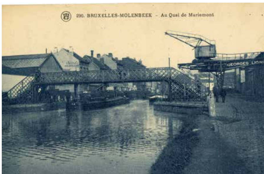
Au Quai de l’Industrie 55-59, grue de la firme Georges Lignian. La passerelle en métal a été remplacée après la guerre par une passerelle en béton précontraint (la première en Belgique) (Collection Musée de Molenbeek). Les établissements DEVIS frères sont installés à côté, au 59).
