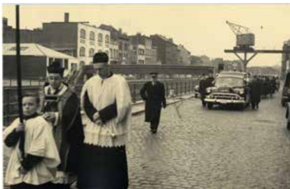
Grue LIGNIAN et la passerelle en béton (SP 2010.0138 - éd. Walschaerts, Bruxelles - Musée Molenbeek).
