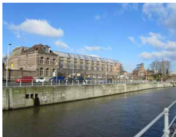
Centrale électrique des tramways bruxellois, vue depuis l'autre rive, 2010 (photo G. Vanderhulst).
