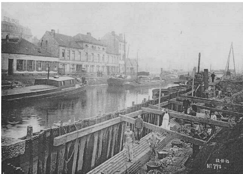
Construction du quai au Boulevard de l'Entrepôt (Archives BESIX).
