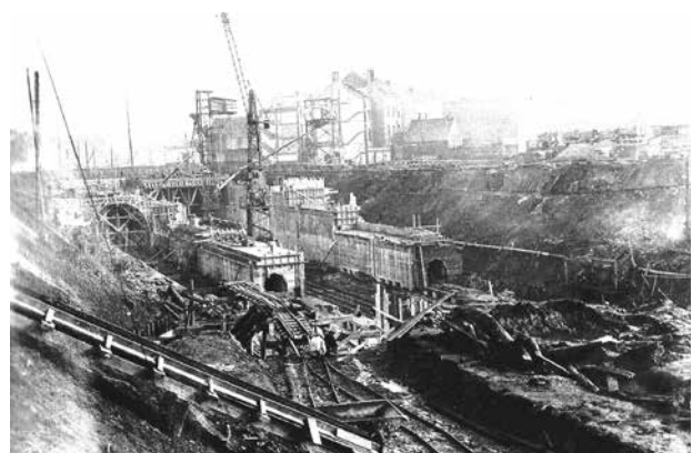
Chantier de l'écluse de Molenbeek, 1930 (Archives BESIX).
