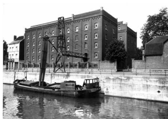
La Meunerie avec suceuse et péniche après 1935. (Fonds G. Vanderhulst).
