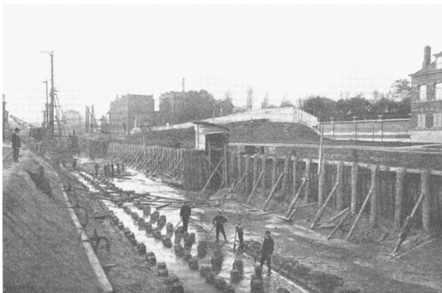
Travaux d'élargissement du canal et de construction des quais, à hauteur de la Centrale des tramways bruxellois – la meunerie Moulart se profile sur l'horizon (Archives BESIX).
