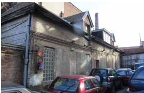
Locaux arrières (anciens ateliers-magasins à bois, réfectoire), (Photo G. Vanderhulst).
